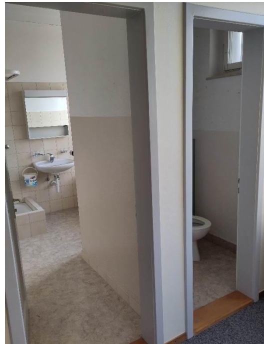
Altes Schulhaus 1. OG: Badzimmer und WC (Ist-Zustand)
